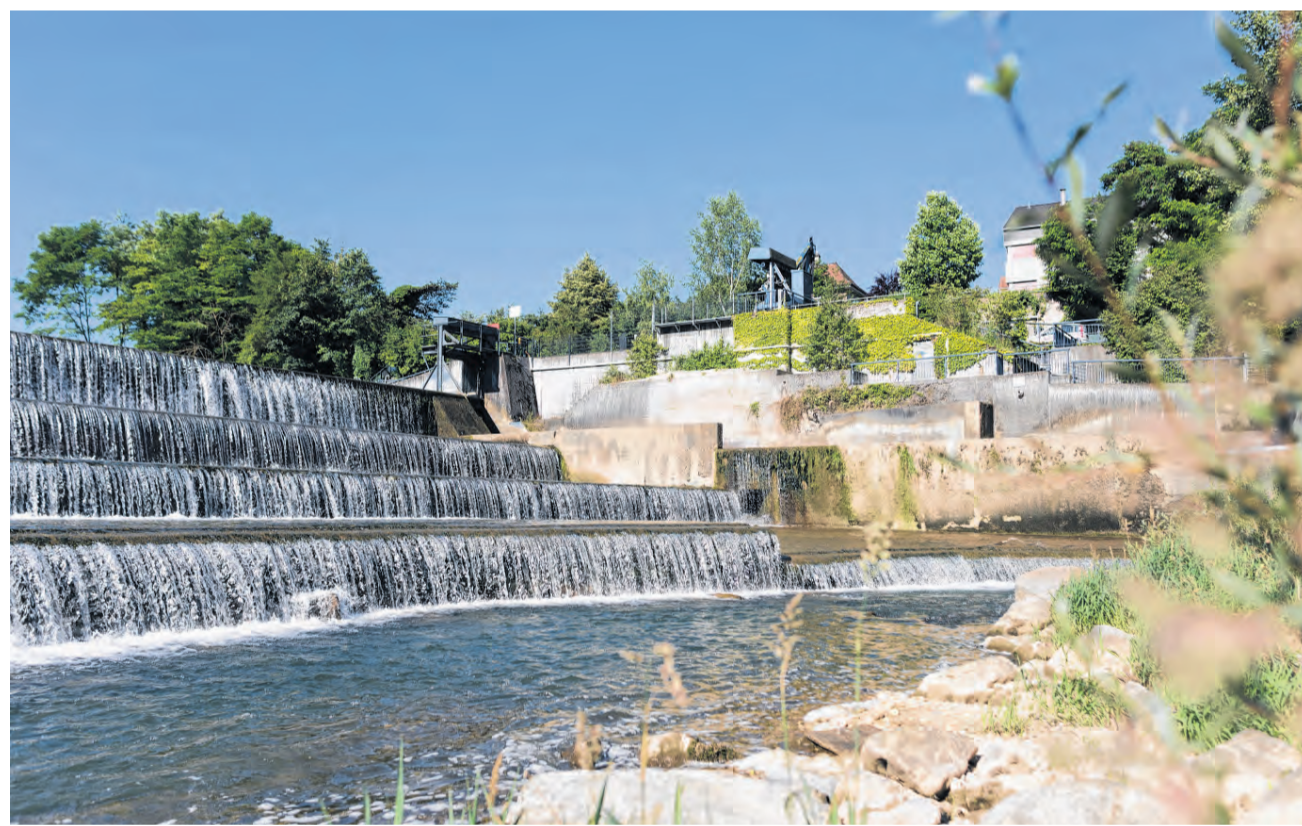
Das Kraftwerk und Wehr Neuwelt in Münchenstein.
