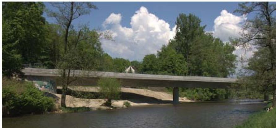
Abb. 22: Zollfreistrasse: Brücke über die Wiese 9
