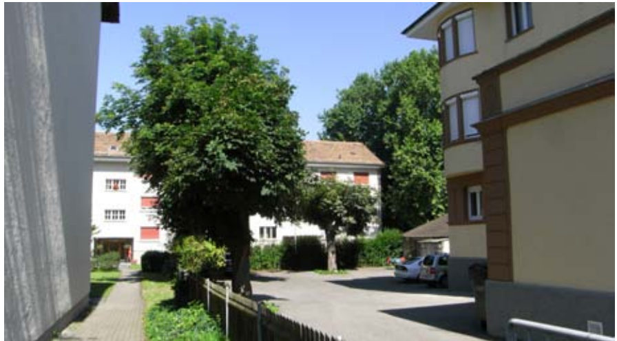
Abb. 74: Mögliche Blickachse zwischen Lörracherstrasse 101 und 105
