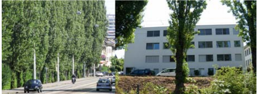
Abb. 34: Geschäftshaus Lörracherstrasse 60 (rechts) und Baumallee (links)
