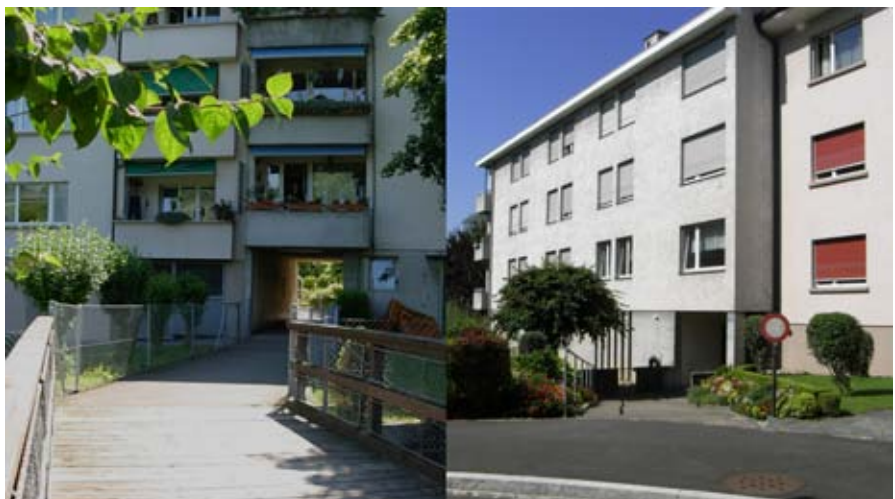
Abb. 57: Fusswegverbindung durch Gebäude Hinter der Mühle 3 zum Weg am Mühleleichen
